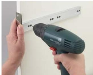
Шаблон для разметки монтажа направляющих полного выдвижения Dynamic XP и Dynamic NT
